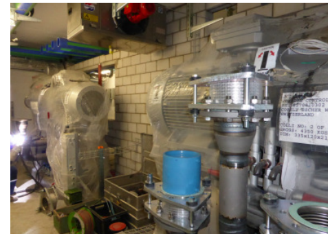
Sabroe NH3 Verdichter vor dem Einbau
