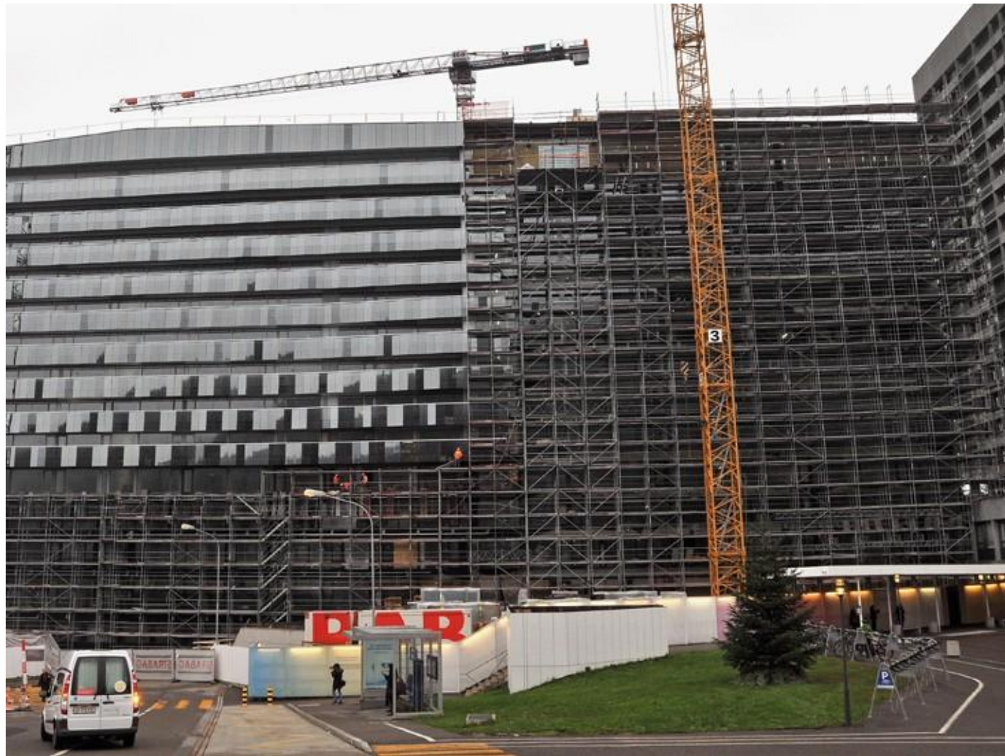
Der langgestreckte Triemli-Neubau steht im rechten Winkel zum bestehenden Spital, das ab 2016 gründlich saniert wird.
