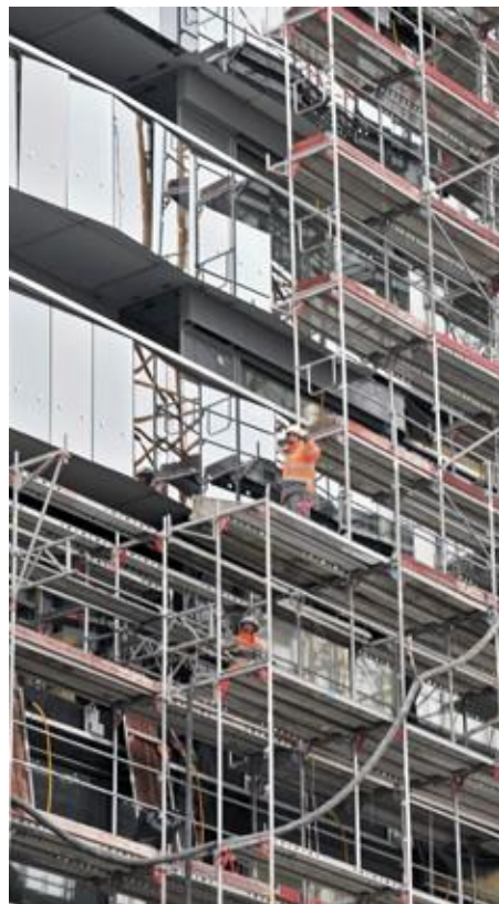
Massarbeit am Laufmeter: Die Arbeiter befinden sich bei der Montag der Glasfassade im Endspurt.
