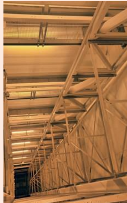
Noch im Bau befinden sich die Multitower, in denen dereinst die verschmutzten und sauberen Betten in zwei separaten Schächten zirkulieren werden.
