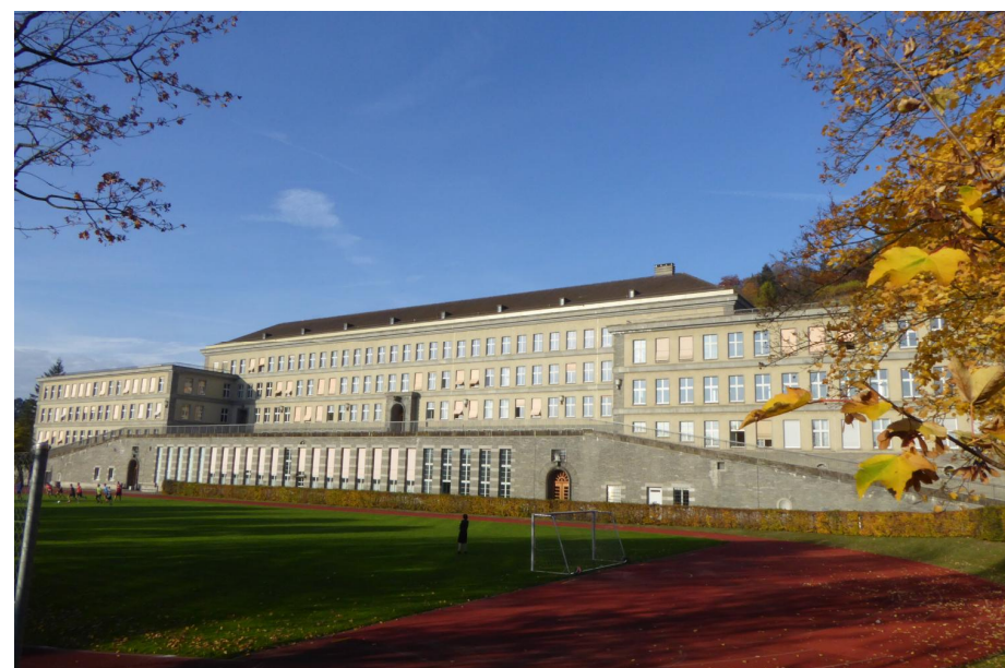
Südansicht Kantonsschule „Im Lee“ Hauptgebäude
